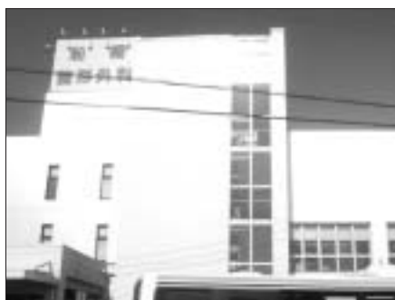
船橋整形外科病院
